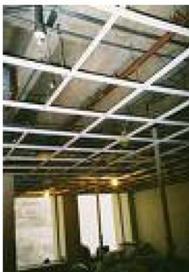
شکل 4: بهسازی و مقاوم سازی سقفهای زیر صافی و پمپ هاو پوشش دادن آنها
