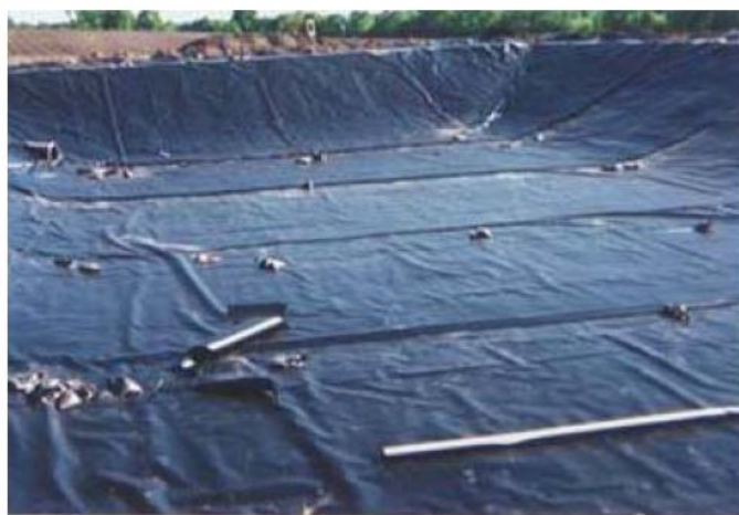
شکل 3: پوشش مجدد مخازن جهت آب بندی کامل و آماده سازی جهت پوشش بتنی مجدد
