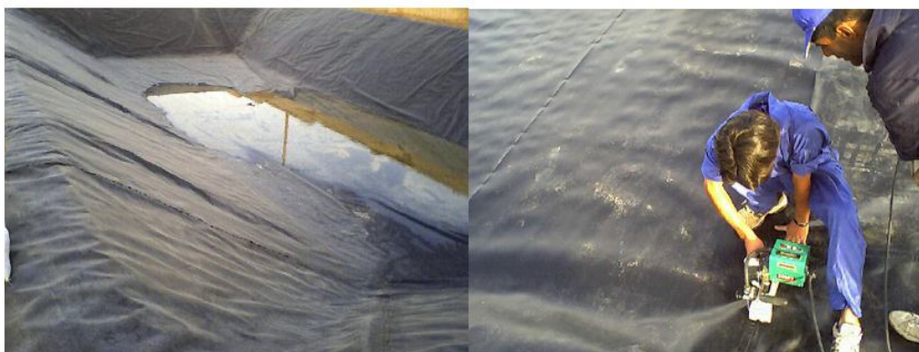
شکل 4: آپارات کردن آب بندها و تست آب بند بودن آن قبل از پوشش دادن
